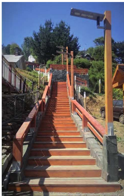
Construcción Escalera Abuelito Huenteyao
