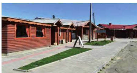
Construcción Paseo Peatonal Calle Simpson, favoreciendo a locales comerciales del lugar
