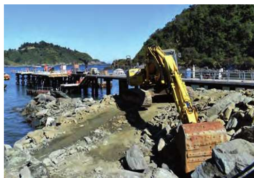
Infraestructura Portuaria Bahía Mansa
