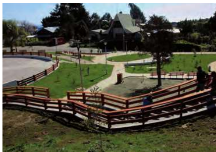
Construcción Plaza Cívica, Bahía Mansa.
