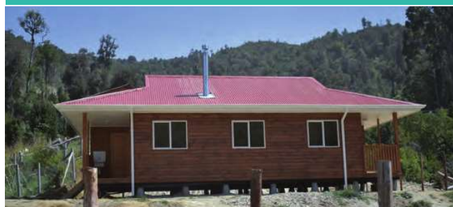
Vivienda nueva para mejorar la calidad de vida
