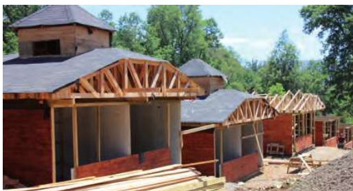
Construcción Centro Comunitario Intercultural y Productivo Misión San Juan.
