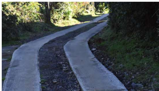
Construcción huellas de hormigón Pasaje Latorre.
