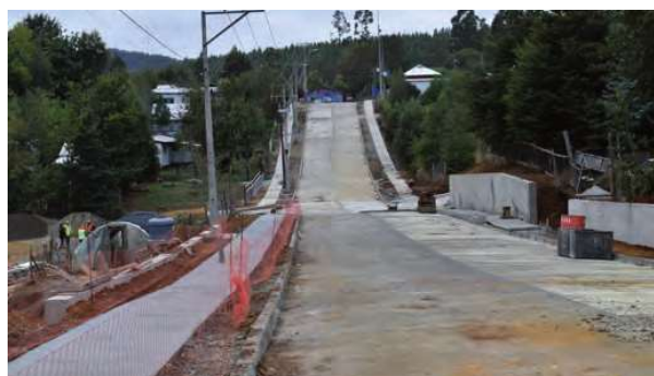
Obras de pavimentación de calzada, aceras y muro contención Calle Nueva Uno Poniente, Puaicho
