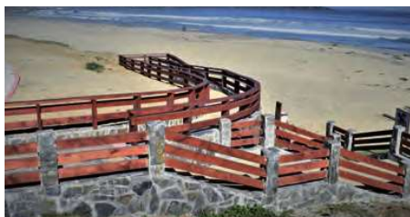
Construcción escalera y acceso universal plaza Maicolpue
