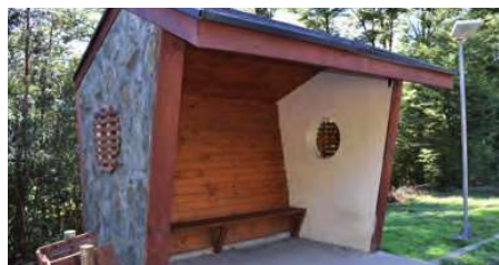
Construcción y reposición paradero en sectores de Quilloimo y Los Radales entre otros.
