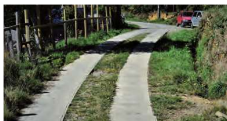
Construcción Huellas de Hormigón Pasaje Maicolpi, Bahía Mansa
